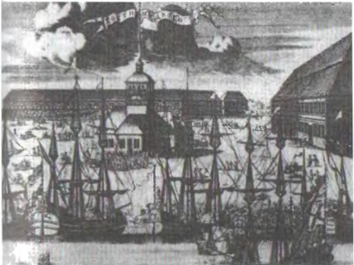
Гостиный двор в Санкт-Петербурге
